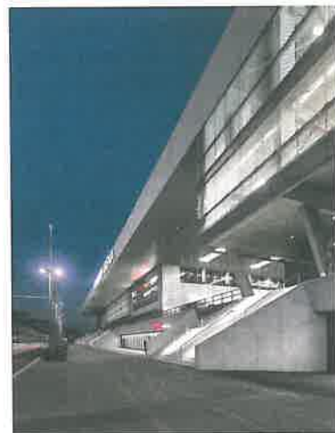
Ein einziges Dach überspannt die Stadien.
